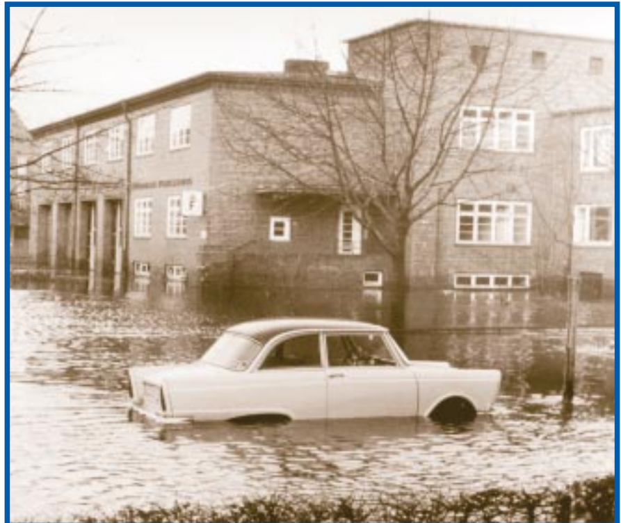
Wie hier in der FuRW Wilhelmsburg wurden auch die Wachen Veddel, Harburg und Steinwerder von den Wassermassen geflutet.
