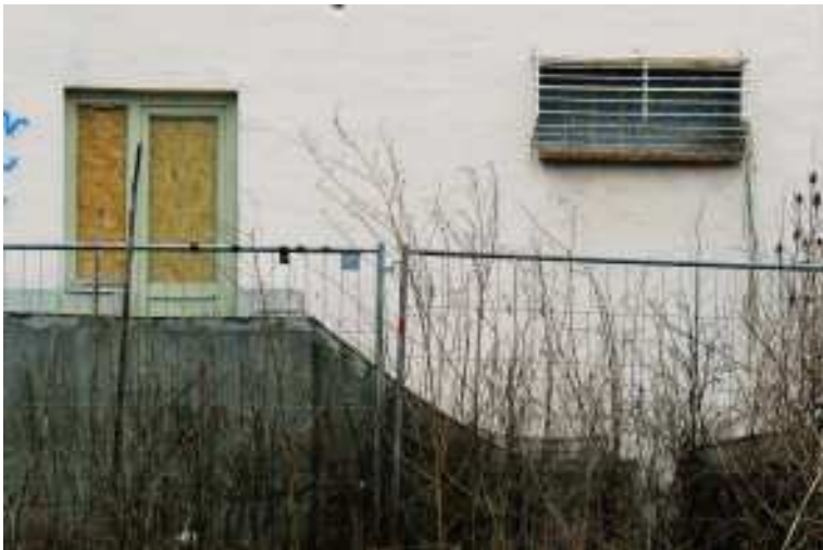
Eine Außentreppe an der Rückfront
