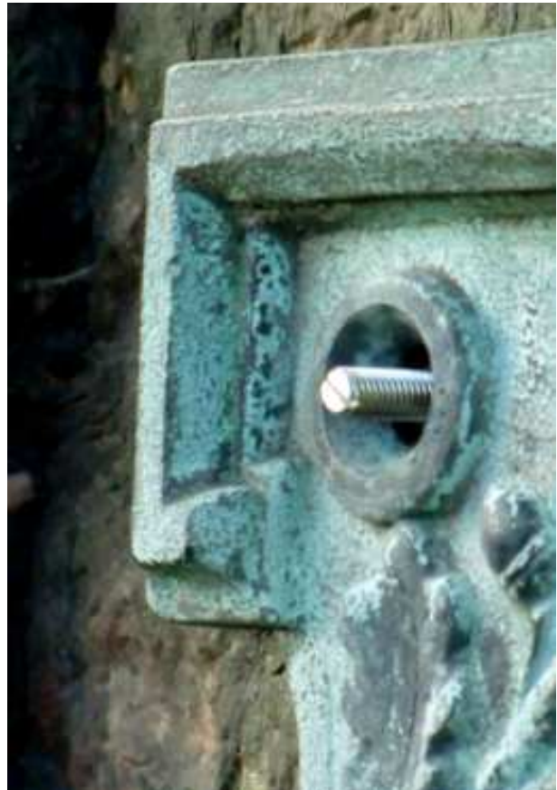
Der perfekt eingesetzte Gewindestab
