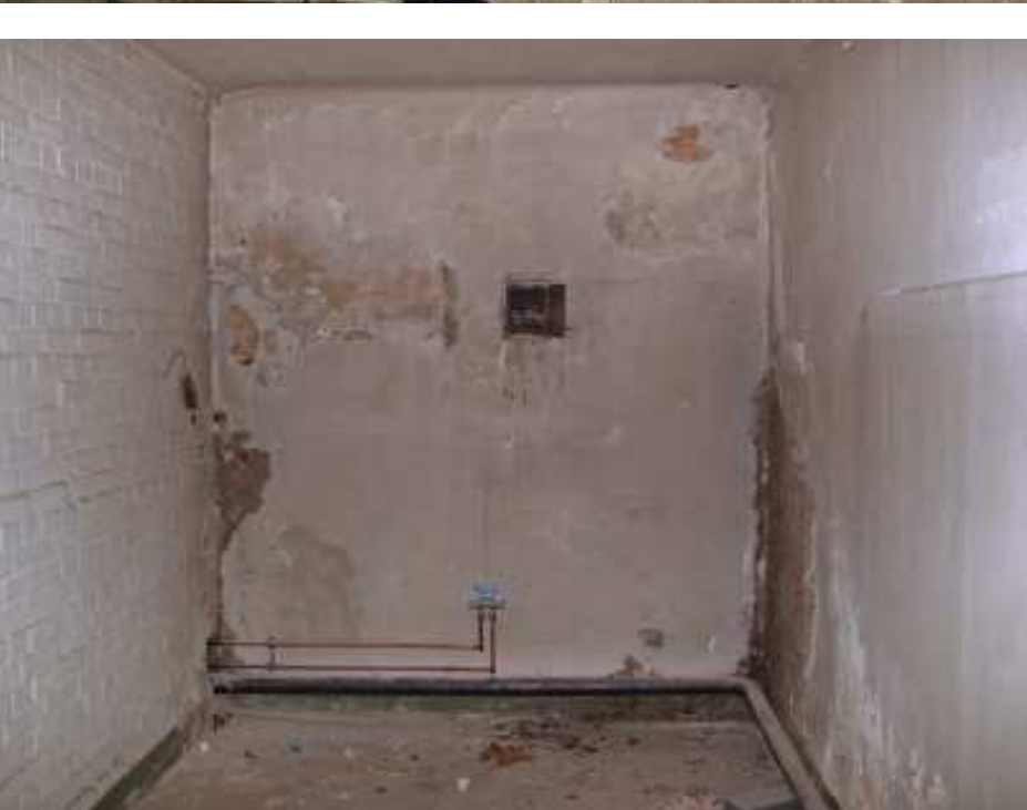
Ein dunkler Nebenraum - ohne Fenster
