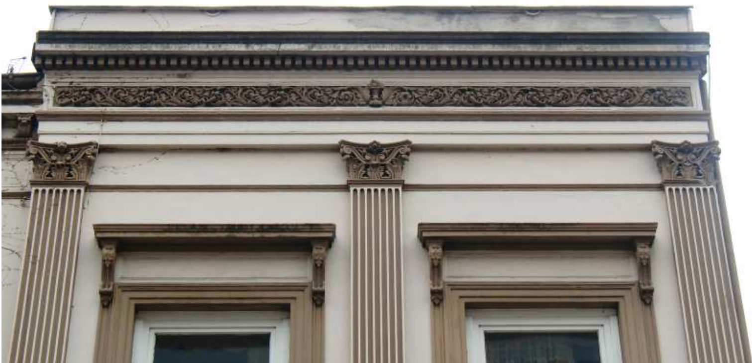
Dieser Fassadenausschnitt zeigt die einstige Schönheit des Hauses
