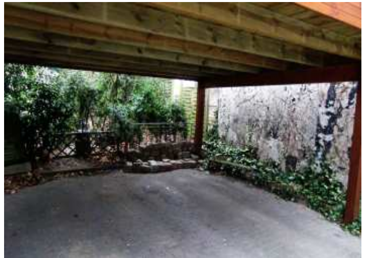
Der Carport auf der linken Gebäudeseite
