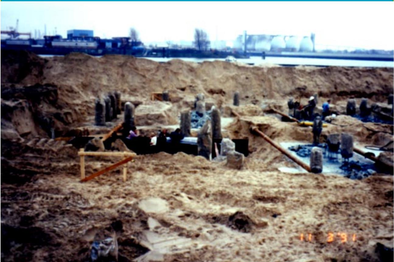
**Bei den aufwendigen Erdarbeiten wurden im März 1991 immer mehr Betonpöller freigelegt, die teilweise mühevoll entfernt werden mussten**
