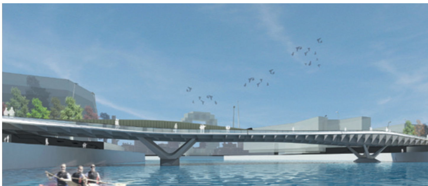
Die 130 Meter lange Baakenhafenbrücke wird ab 2013 den nördlichen Teil des Quartiers mit seinem Südteil verbinden; die ebenso praktisch wie elegant gestaltete Stahlbrücke markiert damit einen Meilenstein für die zügige Entwicklung der östlichen Hafencity (Darstellung aus der Wettbewerbsphase von Wilkinson Eyre Architects, London)
