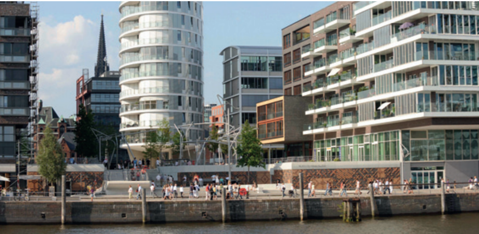
Mit dem Vasco-da-Gama-Platz ist auf dem Warftsockel des Dalmannkais auch ein Quartiersplatz mit Basketballfeld entstanden. Eine Freitreppe verbindet ihn mit der tiefer gelegenen Dalmannkai-Promenade und bietet so unmittelbare Wasserbezüge
