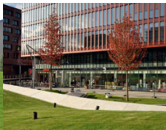
... und das an die Grünfläche grenzende Gebäude SKAI Raum für Büros und Geschäfte
