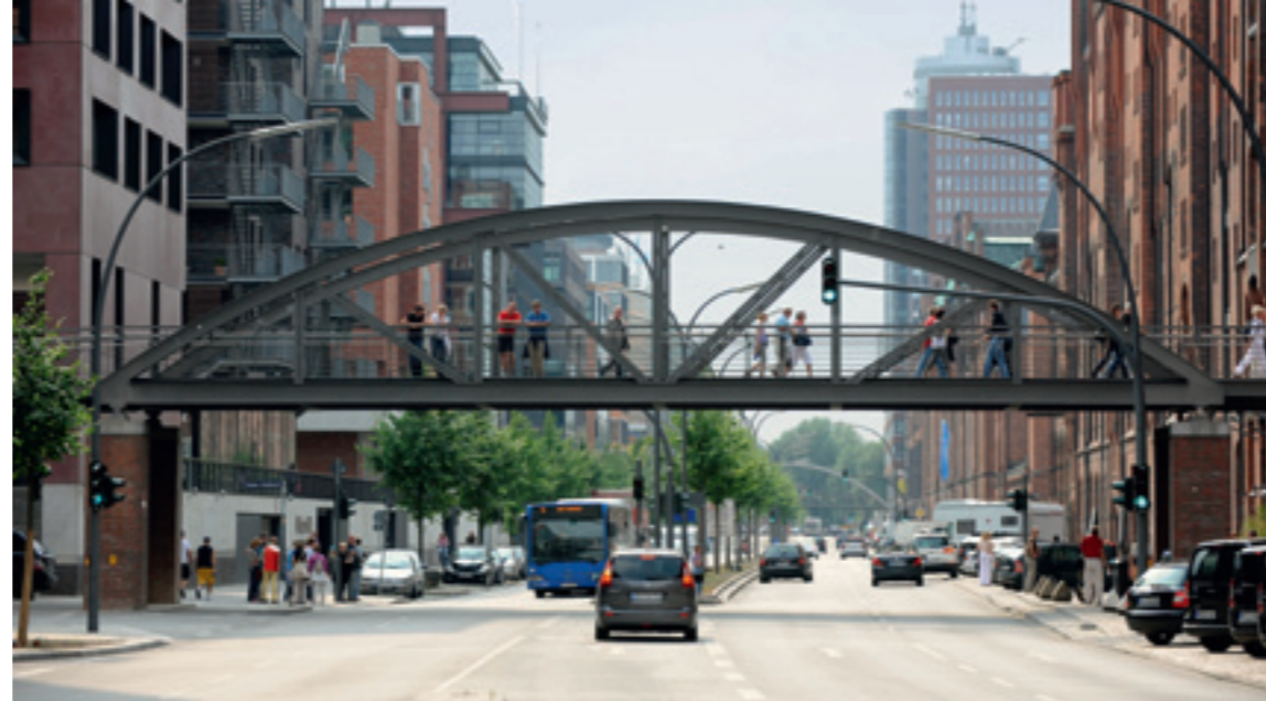
Oberirdisch verbinden die Kibbelstegbrücken bestehende Innenstadt, Speicherstadt und HafenCity miteinander und überqueren die nicht hochwassersichere Straße Am Sandtorkai. Rund 16 Meter unter der Erde ist auch die U4-Haltestelle HafenCity Universität (rechts) im Rohbau fertiggestellt und wird jetzt ausgebaut
