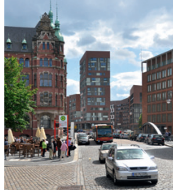
Der markante Wohnturm Arabica bildet das nördliche Entree zum Überseequartier
