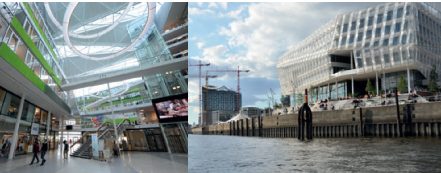
Brücken, Stege und Treppen stellen zahlreiche Verbindungen innerhalb des skulptural geformten Atriums der Unilever-Zentrale her. Vor dem Gebäude bietet u. a. eine große Freitreppe einen weiten Blick über Elbe, Hafen und die wachsende Elbphilharmonie
