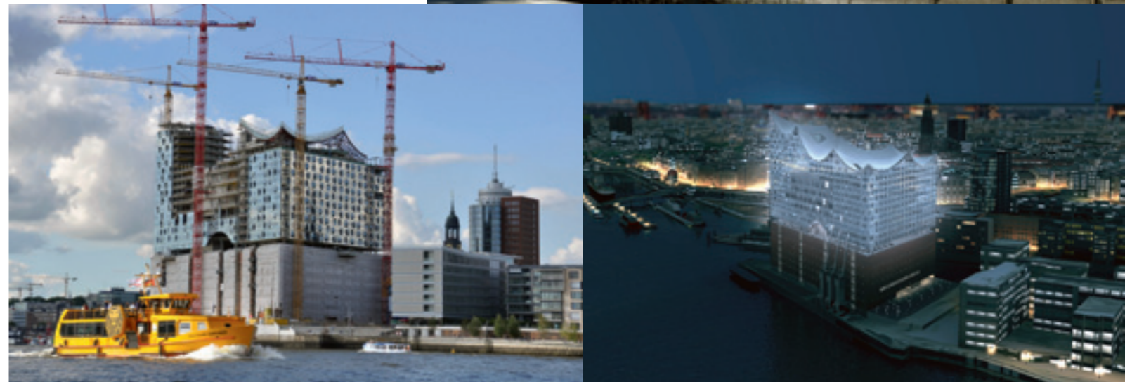
Atemberaubende Architektur, unvergleichliche Lage: Wie eine große gläserne Welle erhebt sich die Elbphilharmonie über dem Gebäude des ehemaligen Kaispeichers A (links: derzeitiger Stand der Bauarbeiten, rechts: Visualisierung des fertiggestellten Konzerthauses)
