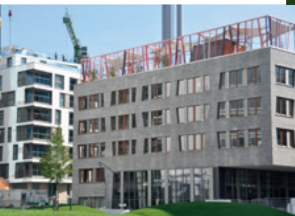
Auf dem Dach der Katharinenschule versteckt sich hinter den bunten Streben ein attraktiv gestalteter Pausenhof
