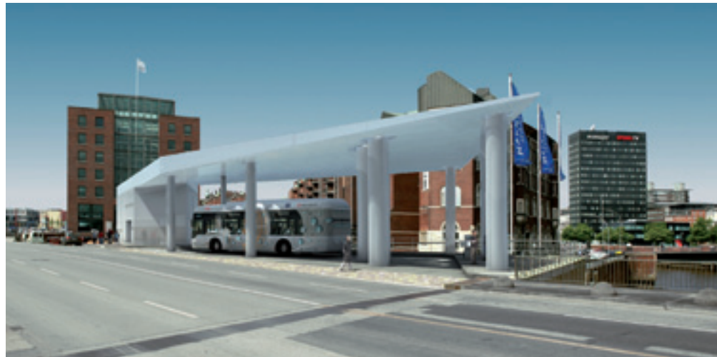
An der Oberbaumbrücke entsteht Europas größte öffentliche Wasserstofftankstelle. Hier wird künftig auch die wachsende Wasserstoffbus-Flotte der Hamburger Hochbahn betankt
