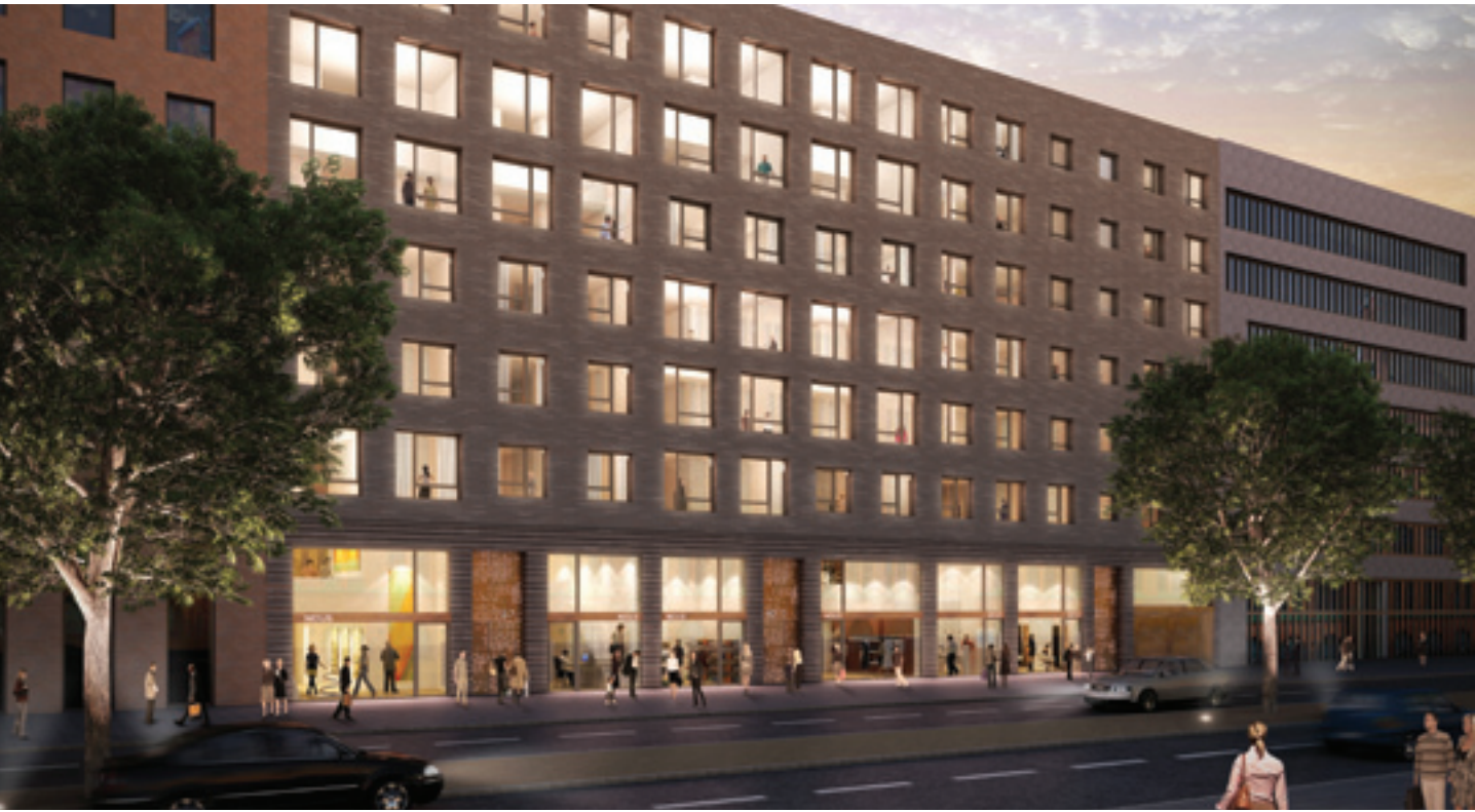
Im Erdgeschoss des loftartigen NIDUS-Gebäudes entstehen Geschäfte, Ateliers und Showrooms, die den Boulevard-Charakter der Shanghaiallee stark prägen. Hinter den großen Schaufenstern entstehen kombinierte Wohn- und Gewerbeflächen
