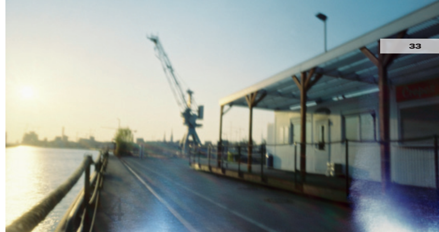
Impressionen aus dem Quartier: Heute wird das Areal als Baulogistik- und Lagerfläche genutzt. Die intensiven Wasserbezüge und der Fernblick über den Hafen zeigen sich allerdings schon jetzt
