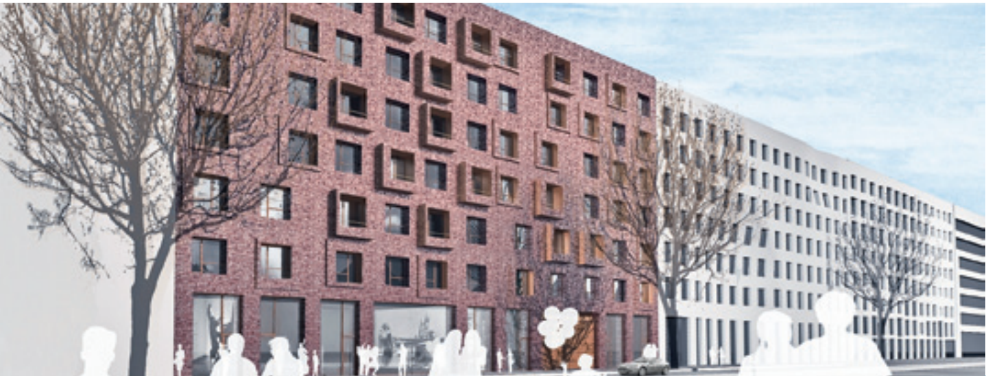
Die in die Wohnungen integrierten, schallentkoppelten Räume der Baugemeinschaft Bürgerstadt AG eignen sich z. B. hervorragend als Übungsräume für Musiker
