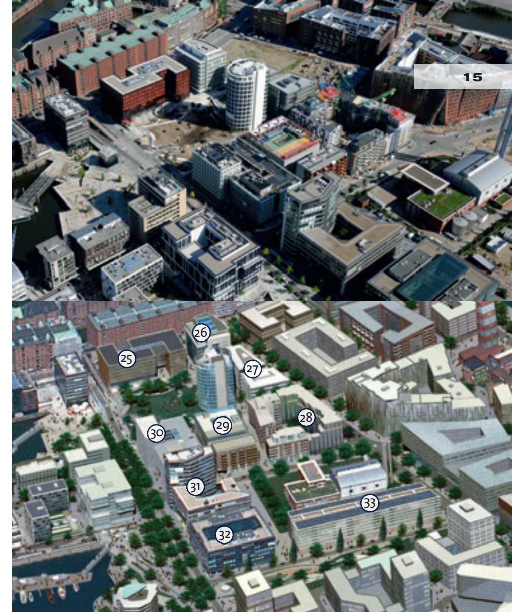
Der Sandtorpark bildet das – inzwischen begrünte – Zentrum des Quartiers. Die Wohn- und Geschäftgebäude gruppieren sich um die Parkanlage, deren Gestaltung auf die südwestlich gelegenen Magellan-Terrassen Bezug nimmt
