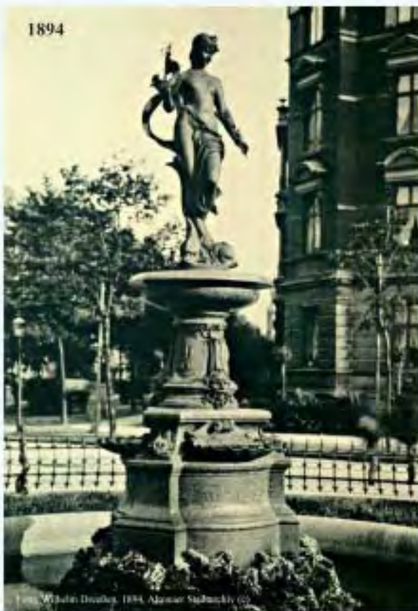
Der Behn-Brunnen an der Goethestraße
