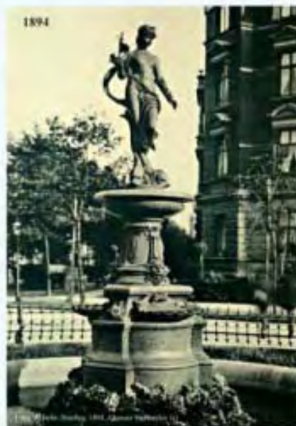
Der Behn-Brunnen an der Goethestraße
