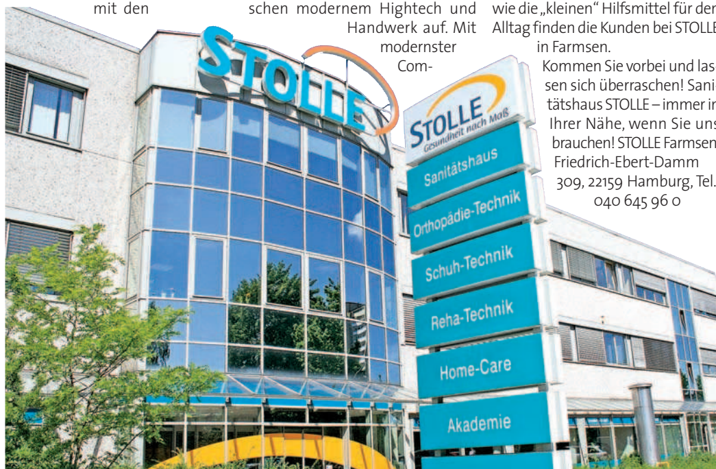
Willkommen bei STOLLE: Die Zentrale des renommierten Sanitätshauses in Hamburg-Farmsen wurde jetzt aufwändig renoviert und präsentiert sich seit Anfang Juni in neuem Gewand. Fotos: STOLLE
