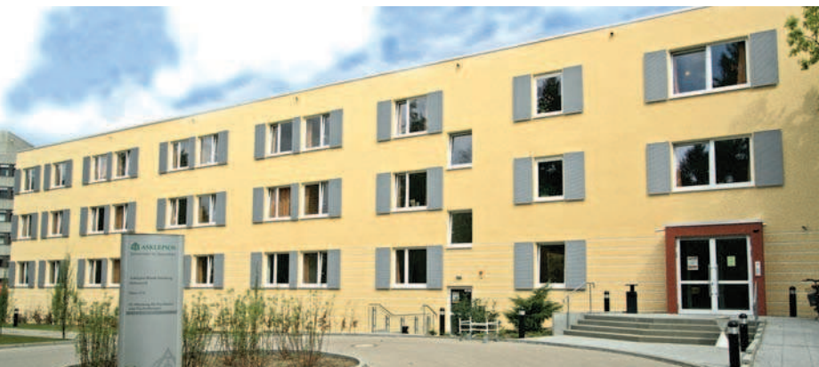
Umgebaut: Haus 17 beherbergt nun zehn Stationen mit 226 Betten und eine Tagesklinik. Foto: Asklepios
