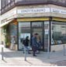
Ziele bald erreicht: Sanierung wird beendet
