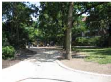
Bauarbeiten im Park an der Goethestraße
