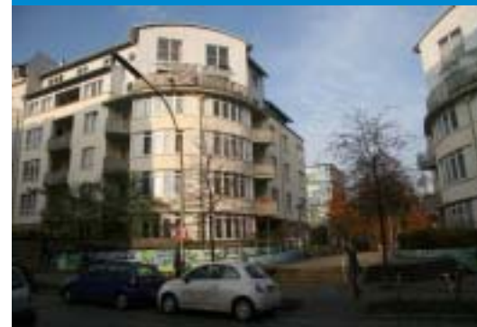
Zwischen 1991 und 2009 wurden 72 neue Wohnungen gebaut.
