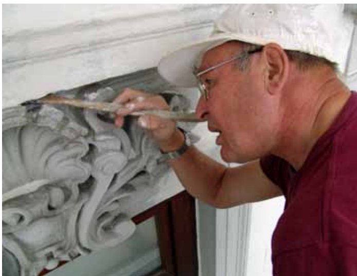
Rudolf Peter legte 2009 bei der Sanierung der Hausfassade selber Hand an.
