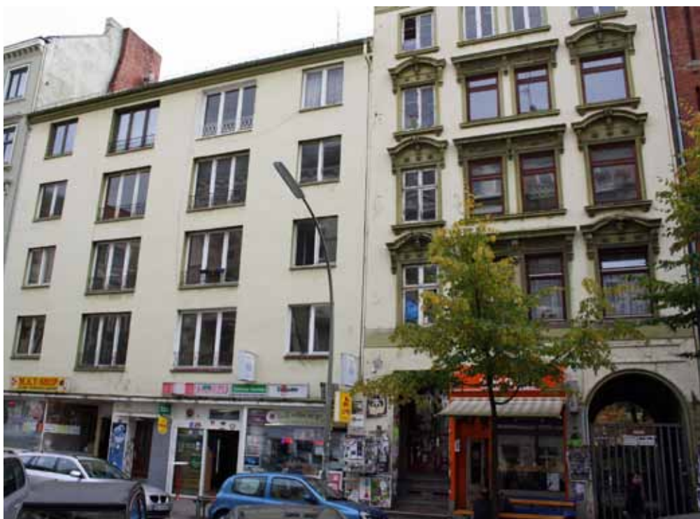
Die beiden Häuser Wohlwillstraße 32 (links) und 34 (rechts).
