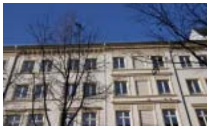
Die Herausforderung: Wohlwillstraße 19-23 ist fertiggestellt Seite 4 - 5
