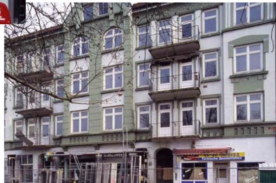
Hier ist eine verbesserte Wärmedämmung in Form eines von außen angebrachten Wärmedämmverbundsystems nicht möglich, da ansonsten die Jugendstilelemente abgeschlagen werden
