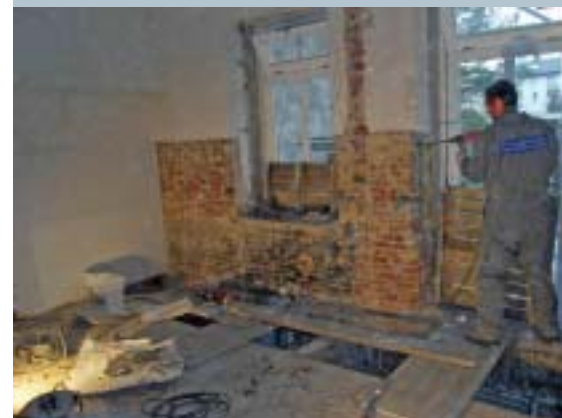
Modernisierung: Umfangreiche Bauarbeiten.
