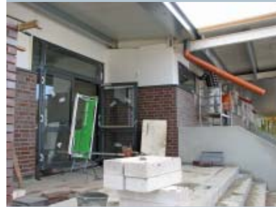
.. sowie mit Rampe, Vordach und Verblendmauerwerk Ende Oktober.
