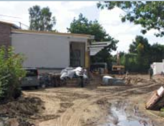
Die Sporthalle während der Bauphase Anfang September ...
