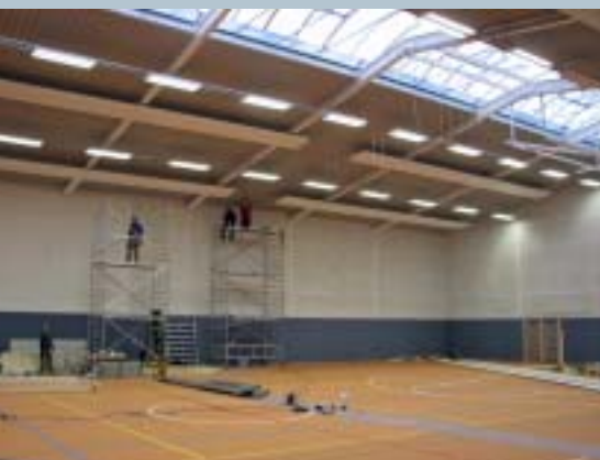
Die Kletterwand wird eingebaut.
