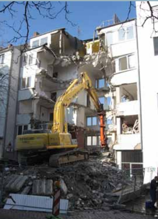
Abrissarbeiten am Nobistor 30.
