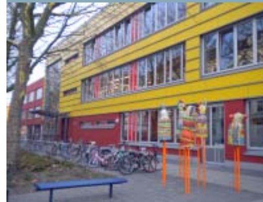
Die neue Louise Schroeder Schule an der Thedestraße.
