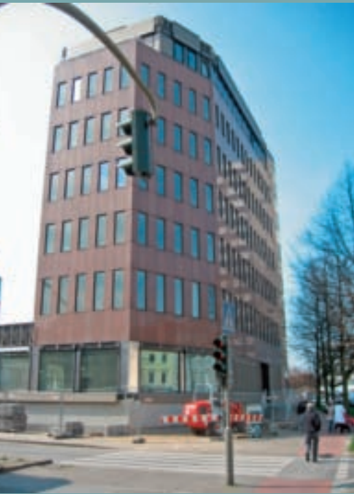
Das neue Technische Rathaus an der Jessenstraße.
