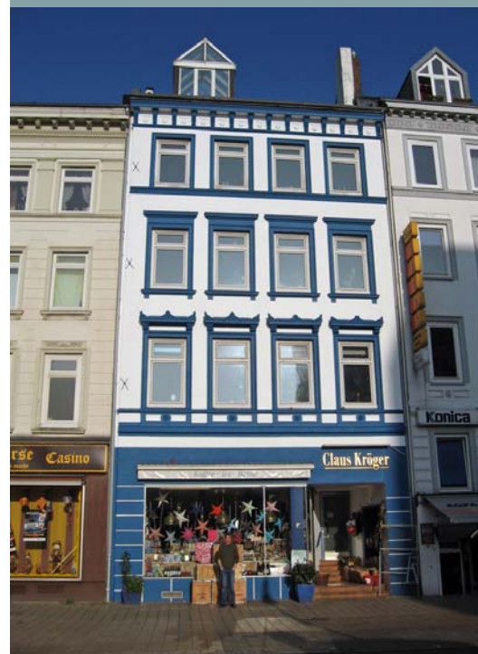
Frisch gestrichen: Juniorchef Florian Kröger vor der sanierten Fassade Große Bergstraße 241.
