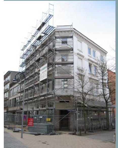
Einrüstung der Großen Bergstraße 199.
