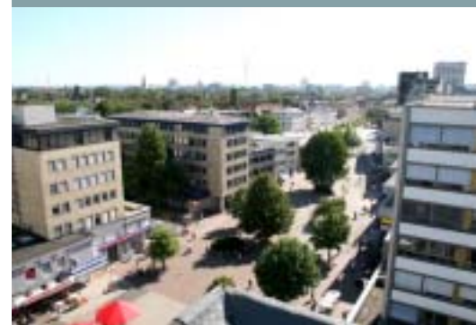
Blick auf die Neue Große Bergstraße
