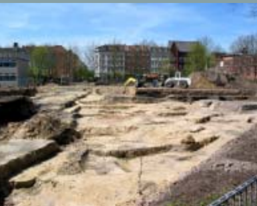
Die Baustelle am Govertsweg
