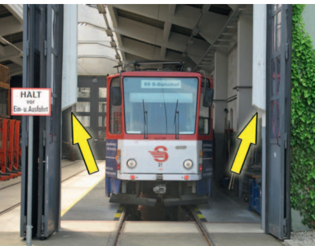
Im Rahmen von Umbaumaßnahmen konnte der Sicherheitsabstand von mindestens 0,5 Meter (bis 2 Meter über Standfläche) hergestellt werden.
