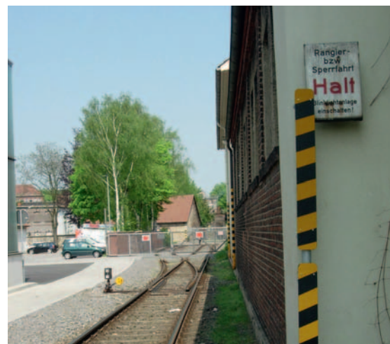
Der Mauervorsprung wurde als Engstelle erkannt. Im Rahmen einer Ausnahmegenehmigung wurden besondere betriebliche Maßnahmen auferlegt.
