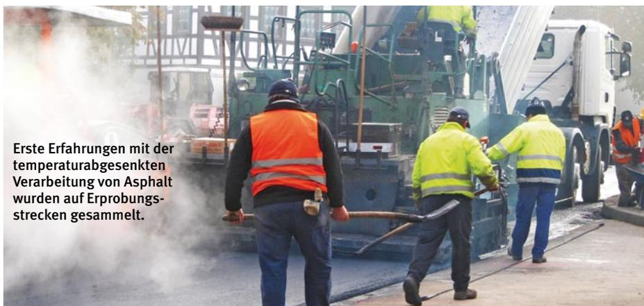
Erste Erfahrungen mit der temperaturabgesenkten Verarbeitung von Asphalt wurden auf Erprobungsstrecken gesammelt.
