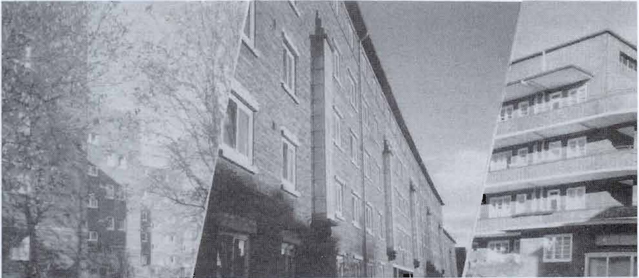
Bild 1: Beispiele für serielle Reihung gleichartiger Elemente: Stufenweise Staffelung des Baukörpers in der Tondernstraße (links), Betonung der Treppenhäuser als regelmäßig wiederkehrendes Element, das die nüchterne Lochfassade an der Nordschleswiger Straße (Naumannblock) strukturiert (Mitte) und Abschluß des Laubengangs bei den Frank-Häusern in der Oberschlesische Str. (rechts).
