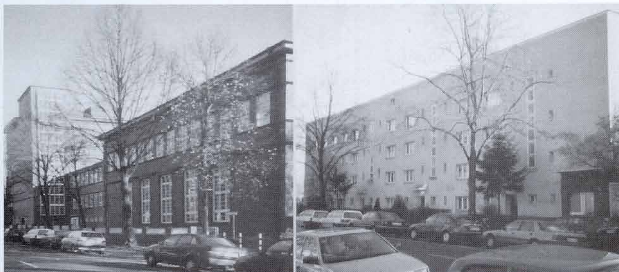
Bild 2: Kubische Grundform: Gesamtschule Alter Teichweg: flache Dächer und Gliederung der BACKSTEIN-Fassade durch waagerechte bzw. senkrechte Fensterreihen (links); nach Sanierung neuerdings verputzt: der Rest der ursprünglichen Bebauung am Nordmarkplatz (rechts)
