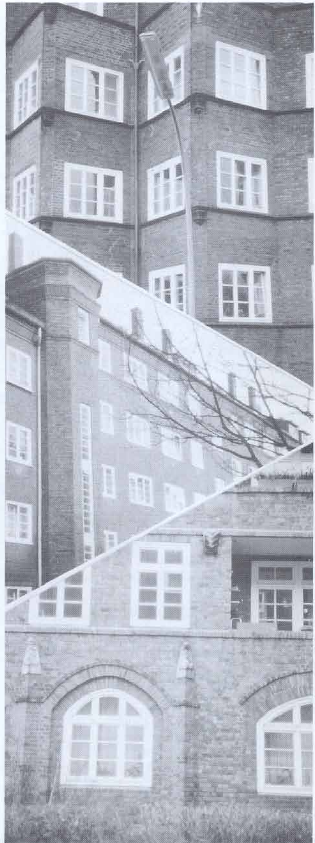
(1) Beispiele zur vertikalen Gliederung der Fassade. Im oberen Bild (Adlerstraße) zwei nebeneinandergesetzte „Dreieckserker“ (sog. „gefaltete Fassade“), im mittleren Bild (Schwansenstraße) ist ein deutlich vorspringendes Treppenhaus zu sehen, das die Dachlinie durchstößt. Im unteren Bild (Angelnstraße) finden sich ebenfalls Dreiecksvorsprünge, hier mit (reichlich) plastischem Bauschmuck (Beton), zusätzlich sind die Bogenfenster im Erdgeschoß zu beachten.
