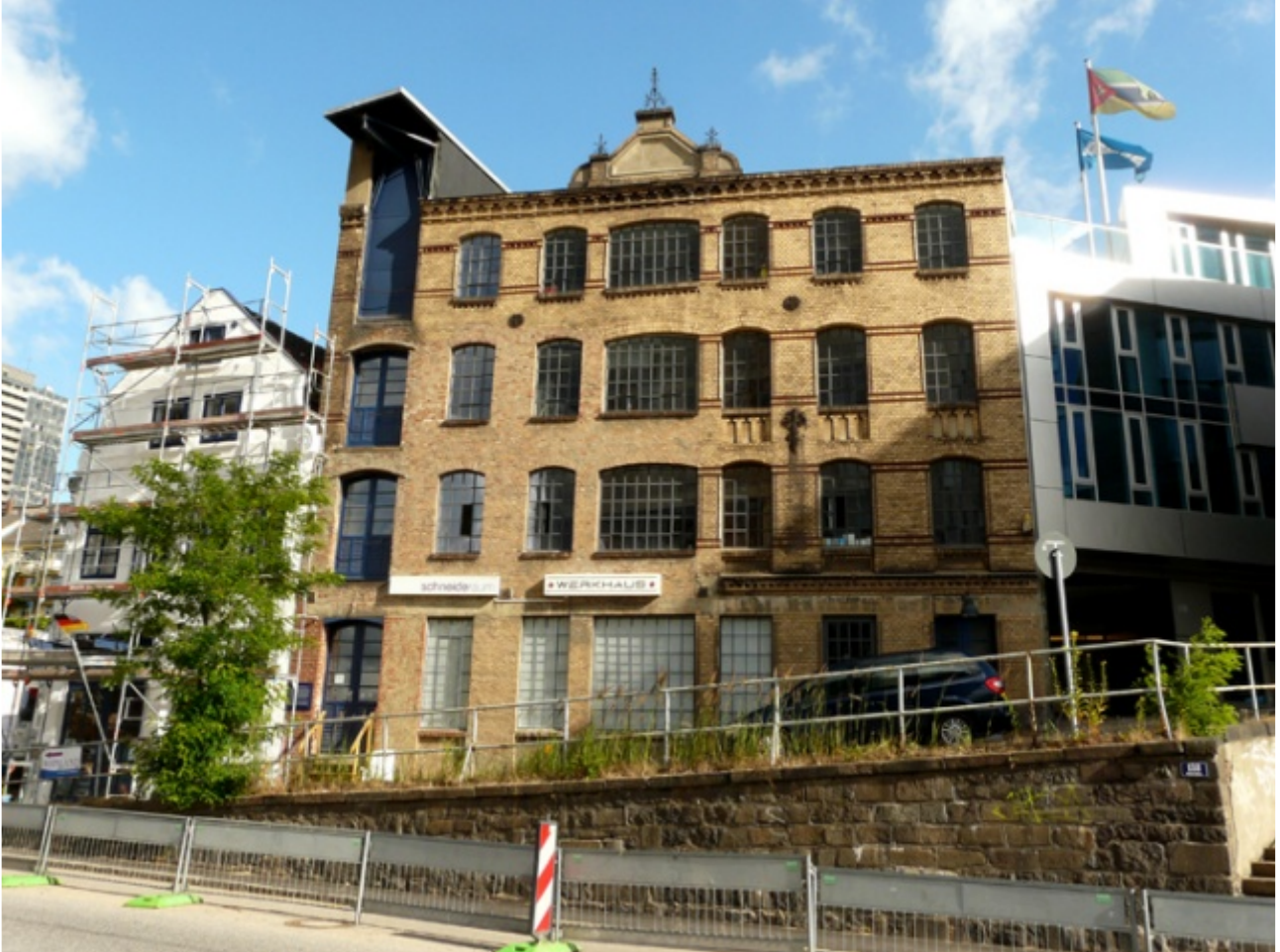
Das alte Fabrikgebäude der Fa. Groth und Degenhardt an der Gr. Elbstraße 146 - am Altonaer Hafenrand. Links daneben steht Altonas ältestes Haus. An der Vorderfassade des Hauses sind sog. „Maueranker“ zu erkennen
