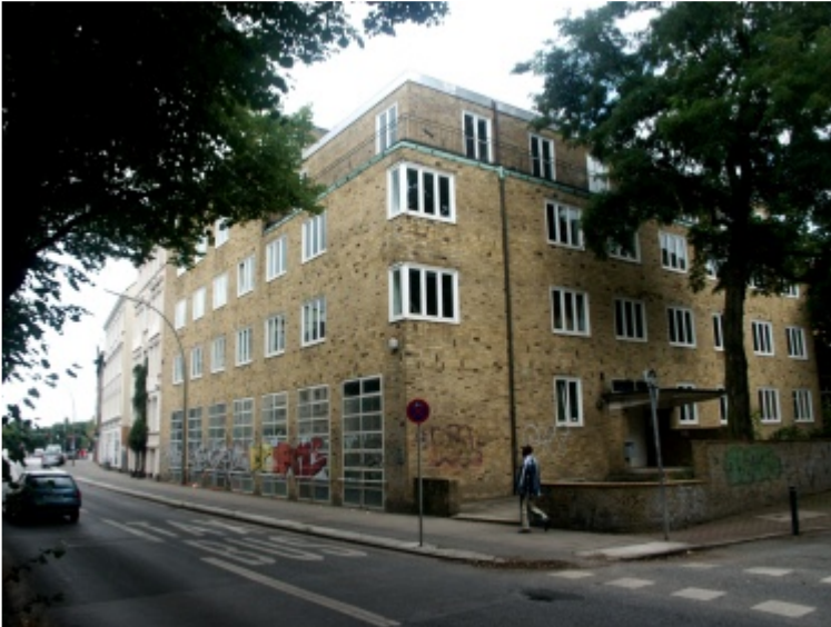
Das Schwesternhaus des ehemaligen Altonaer Krankenhauses an der Max-Brauer-Allee (früher Allee) im Jahre 2005
