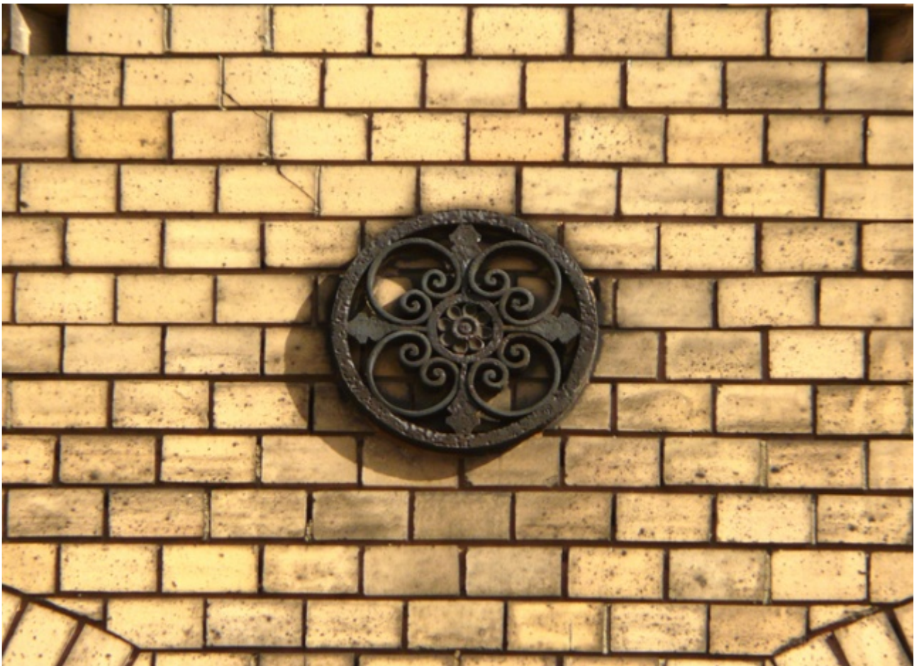
Diese Abbildung zeigt einen künstlerisch gelungenen Maueranker am Oberteil der Fassade
