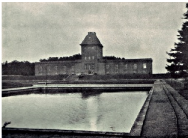
Altonaer Wasserwerk auf dem Bours Berg
