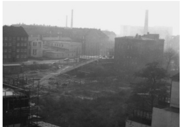
Diese Aufnahme stammt aus dem Jahre 1961, als das alte "Polizeigefängnis" in der Kleinen Mühlenstraße (heute Struenseestraße) abgerissen wurde, um dem Neubau der Schule Königstraße zu weichen.
