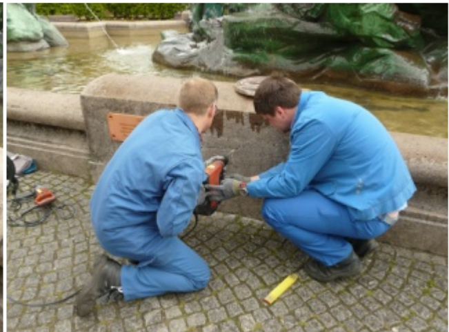
Das Bohren der neuen Löcher
