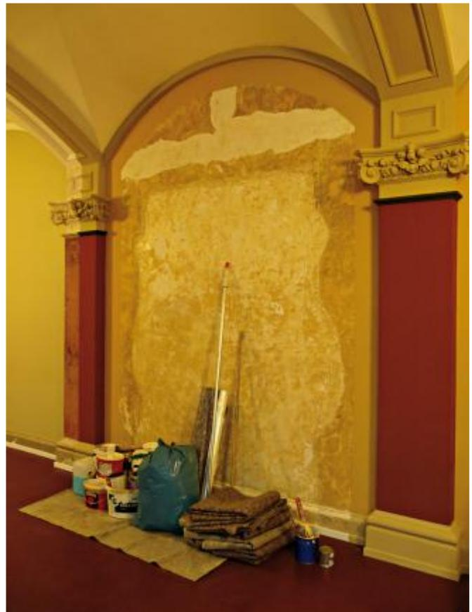
**Diese Abbildung zeigt die Flurwand des Rathausflures, hinter der sich heute der Kollegiensaal befindet. Wie man erkennen kann, wurden die in den über einhundertzehn zurückliegenden Jahren aufeinander aufgetragenen Farbschichten bis auf aus Mauerwerk zurück abgetragen, um erfahren zu können, wie die Farbe des ersten Wandanstrichs 1898 einmal ausgesehen hatte.**
