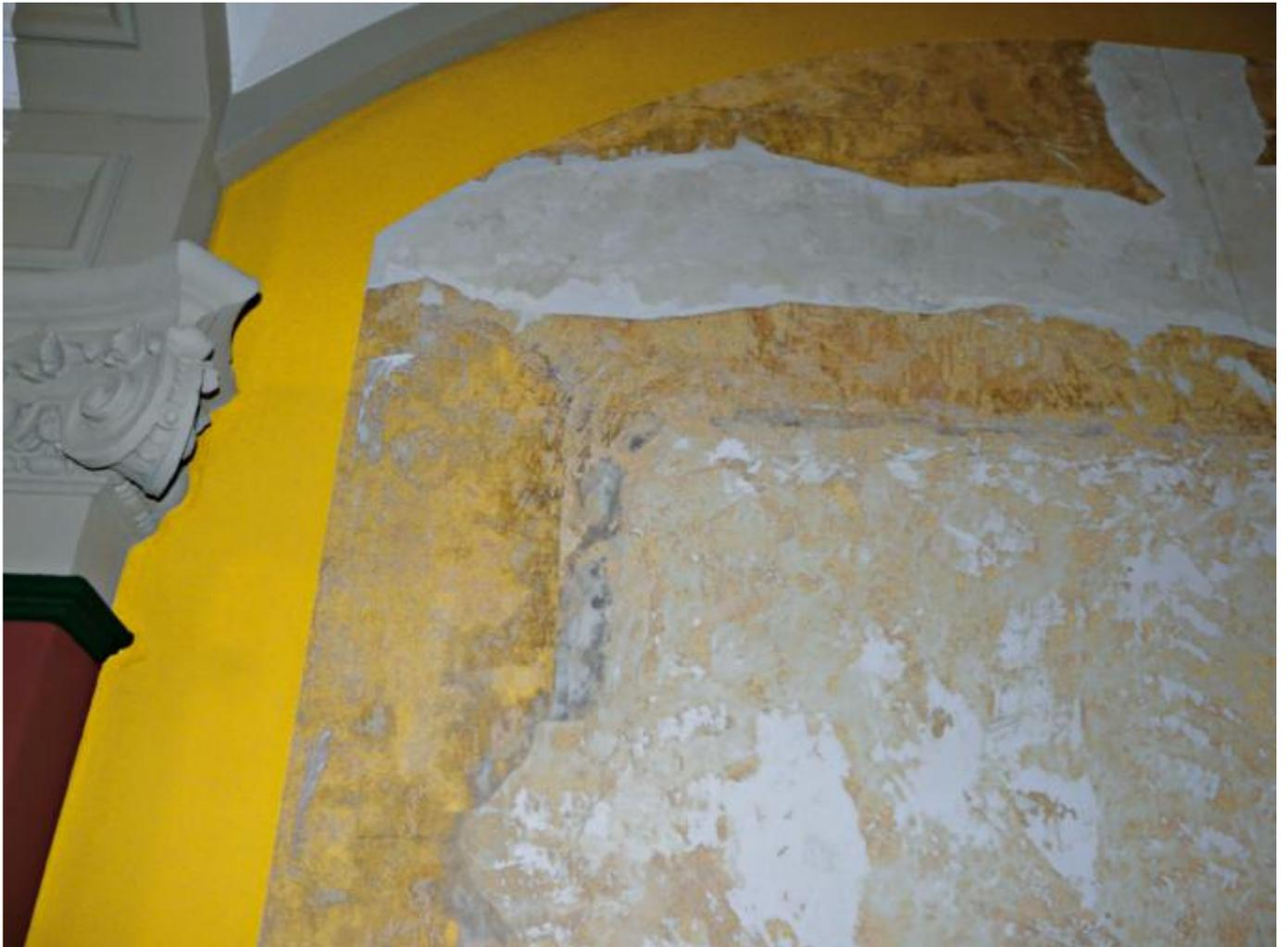
**Auf diesem Bild sind einzelne der freigelegten Farbschichten gut zu erkennen. Sogar Spuren eines Rahmens sind noch in der Bildmitte zu erkennen. Links im Bild ist bereits zur Probe und Gegenkontrolle die gelbe Farbe aufgetragen worden, die dem alten Anstrich sehr nahe kam**
