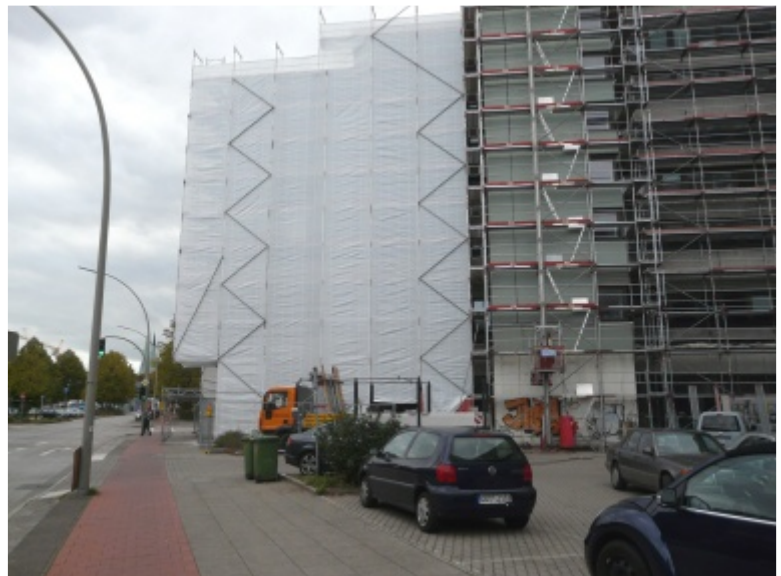
Die eingerüstete Fassade des Forums in November 2009
