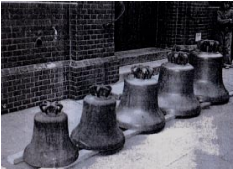
Die neuen Glocken wurden 1975 vor der Kapelle aufgestellt und wurden später per Hand am Seil in den Glockenturm gehoben.
