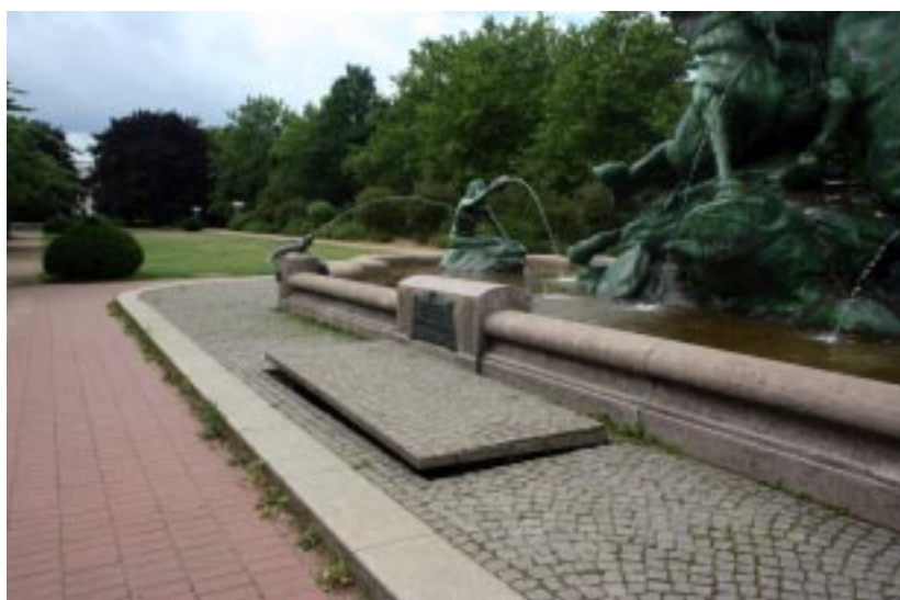
Die hoch gehobene Bodenplatte
