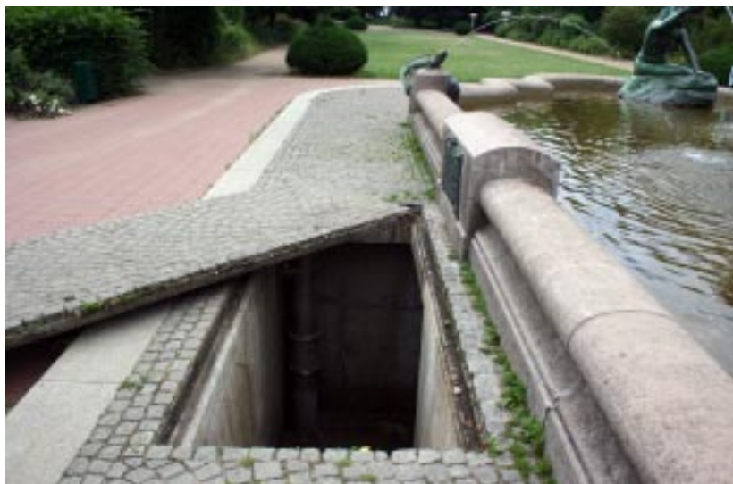
Der nun frei gegebene Zugang zum Brunnenkeller
