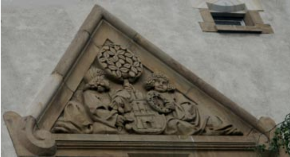
Das Gymnasium Allee von 1906, eine Altonaer Bildungsanstalt mit langer - mit dem Stadtteil verbundener - Tradition. Sogar das Altonaer Stadtwappen prangt noch noch oben an der Vorderfassade des Schulgebäudes
