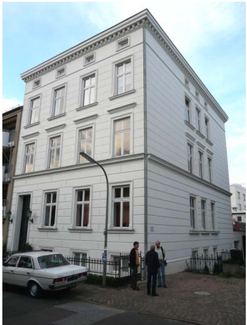
Das Haus mit dem historischen Eiskeller in der Lessers Passage 4
