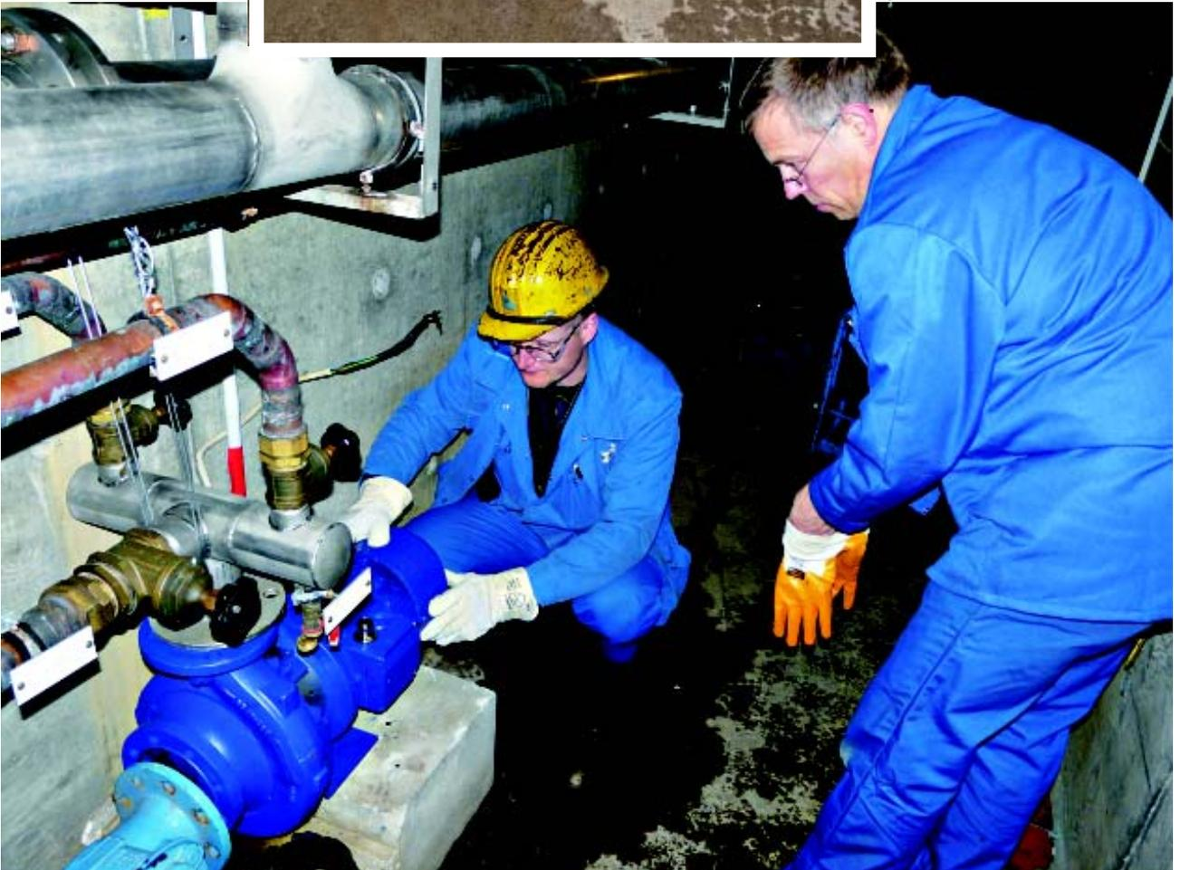
*Weil die Anschlüsse der alten Pumpe nicht mehr passten, mussten umfangreiche Änderungen am Rohrsystem vorgenommen werden, damit die neue Pumpe angeschlossen werden konnte*
