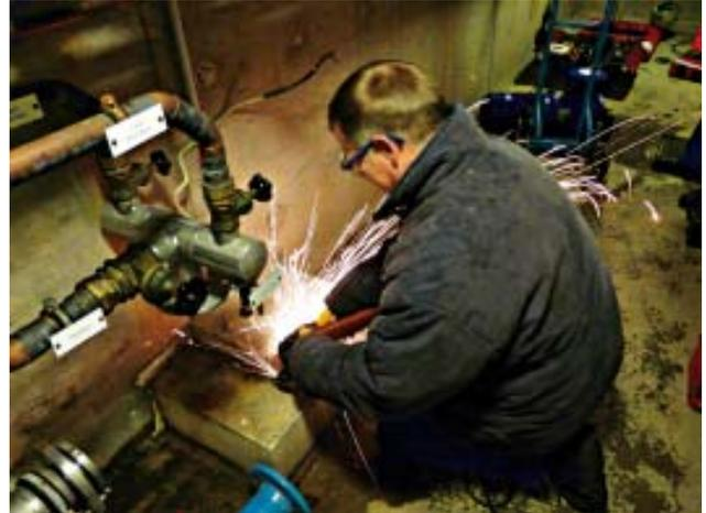
*Wolfgang Marksch entfernt die nicht mehr passenden Schraubenbolzen mit einer Flex vom Betonsockel (links)*
