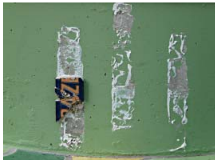
So sah der gesamte beschädigte Namenszug am Brunnen aus...
