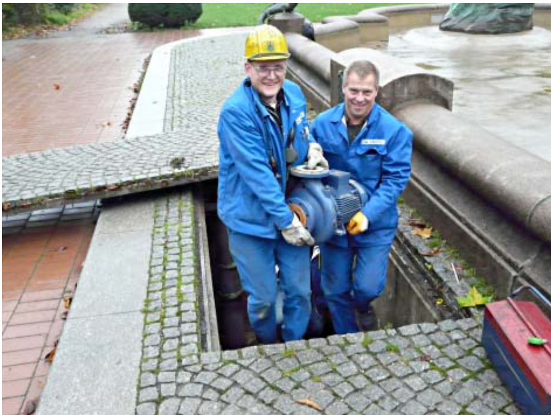
Abtransport des eisernen „Patienten“. Ob er überleben wird, muss sich später noch herausstellen. Pumpe und Hydraulik werden repariert...
