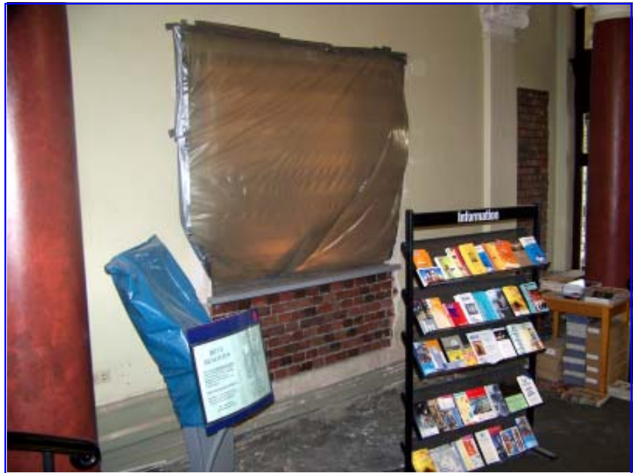
Eine Aufnahme von den Umbauarbeiten und Modernisierungen des Auskunftsbereiches
