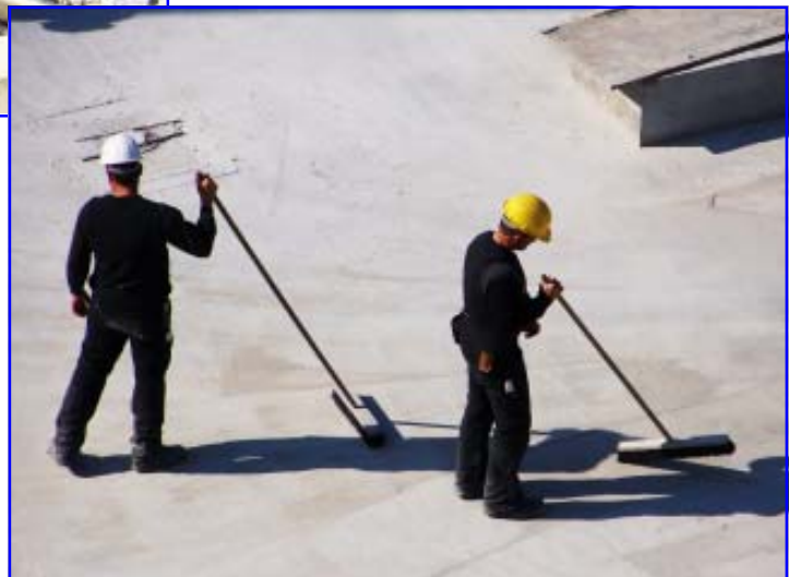
Ein herrliches „Besenballett“ auf dem Dach...
