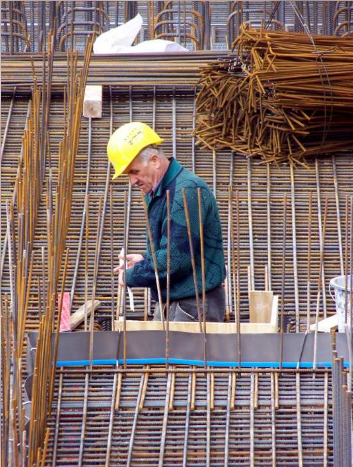
Diese Fotoansicht entstand auf der Baustelle für den Anbau der Endo-Klinik an der Holstenstraße
