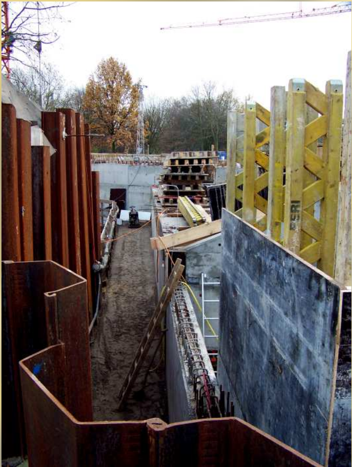
Impression von der Baustelle des „Festland-Bades“ an der Holstenstraße
