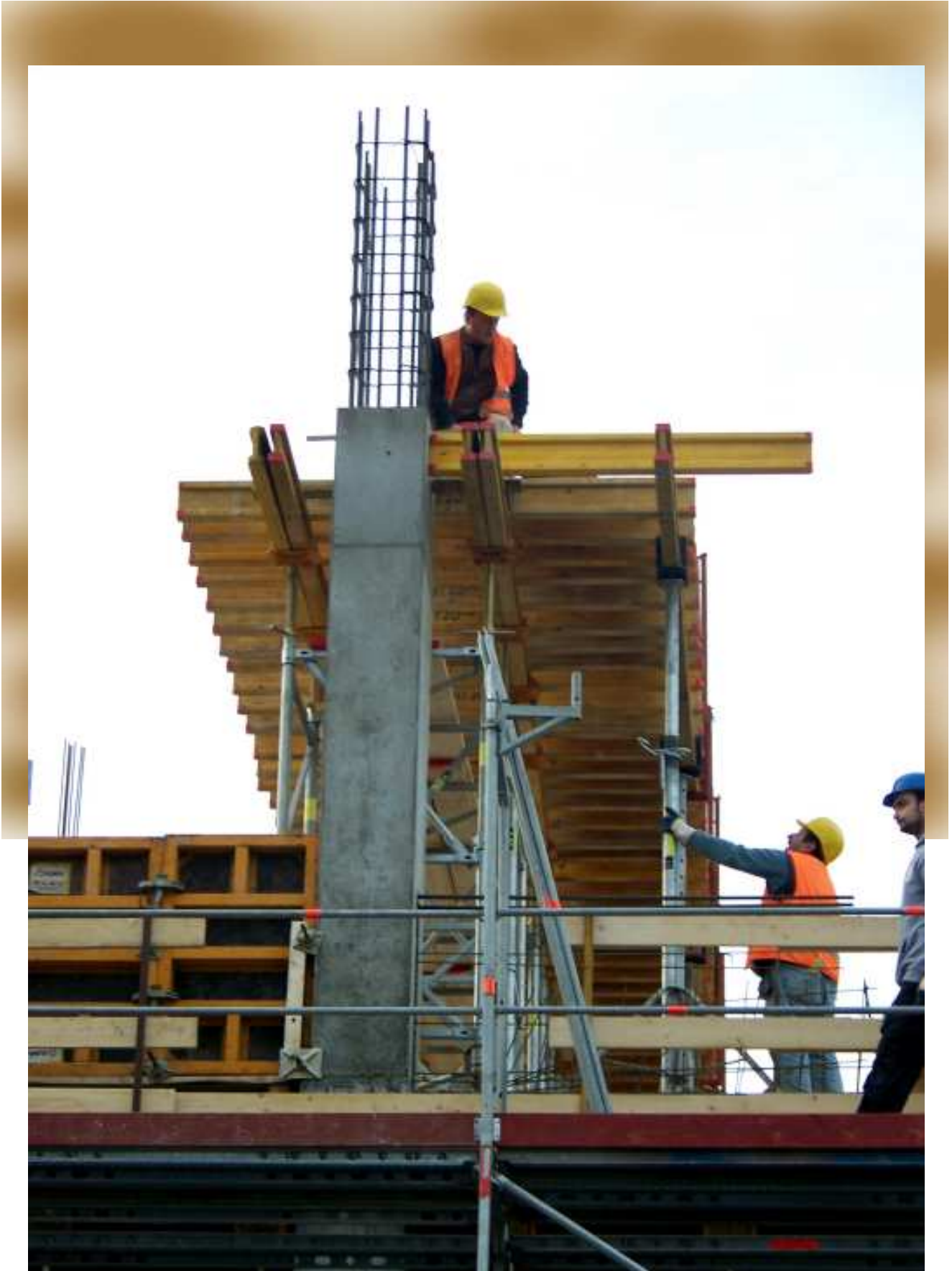
Aufnahme vom Bau des neuen Anbaus für die Endo-Klinik an der Holstenstraße
