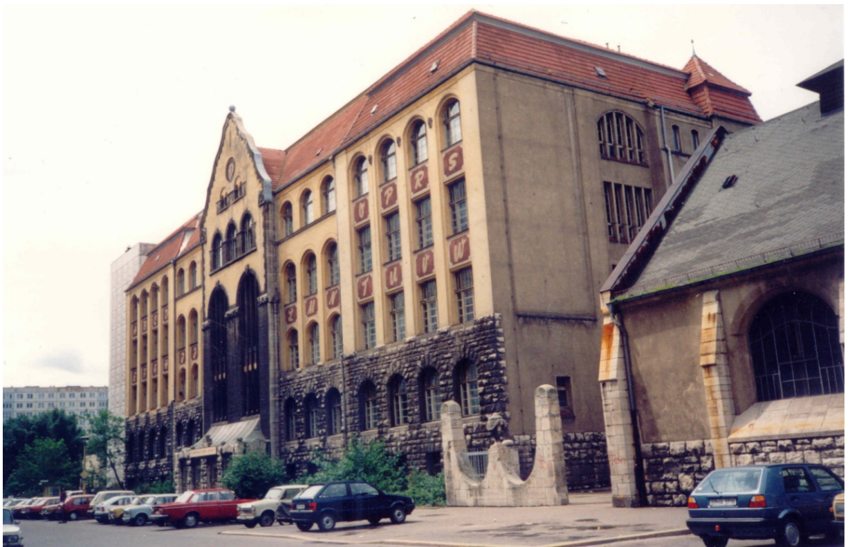
Abb. 1: Heutiger Altbau der »Mildred-Harnack-Oberschule«, rechts die angrenzende Turnhalle (Foto: Elke Sabrowski, 1991)
