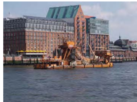
Baggerarbeiten im Hamburger Hafen. (Foto: Calmano)
