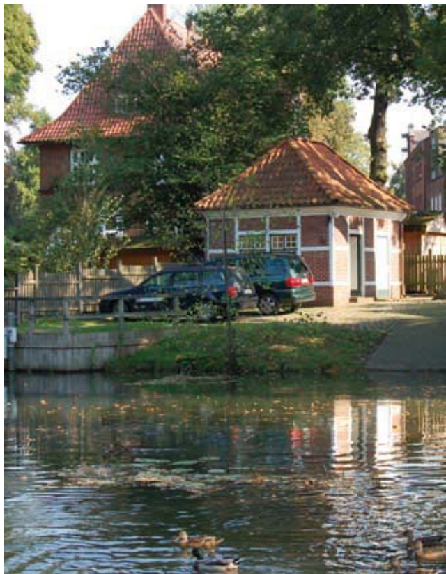
Wassergütemessstation Fischerhof in Bergedorf: modernste Technik in alten Gemäuern
