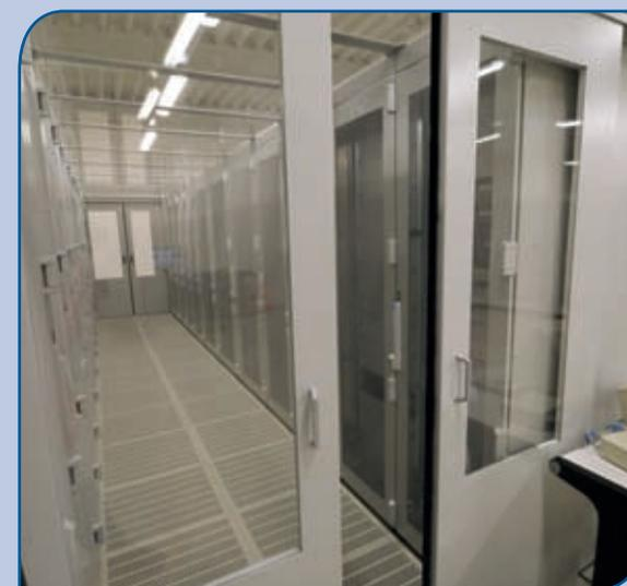
Thermische Isolierung der Kaltgänge verhindert eine Vermischung der Luftströme und verbessert damit die Leistungsfähigkeit der Klimaanlage und der Kühlung.
