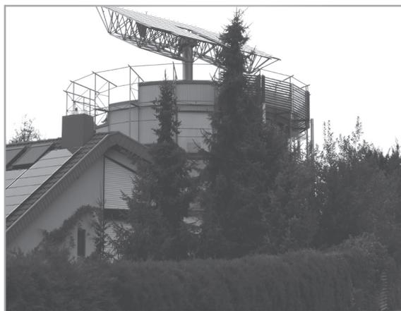
Dieses Gebäude ist in der Lage, sich je nach Sonneneinstrahlung um 40 Grad zu drehen. Damit wird eine optimale Wirkung der Solarenergie erzielt.
