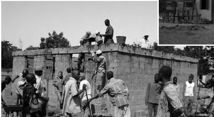
Tatkräftiger Einsatz in Kannaré (Niger) – eine Schule entsteht
