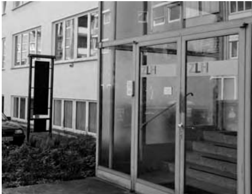
Eingang zum Gebäude des Zentrums für Lehrerbildung Hamburg
