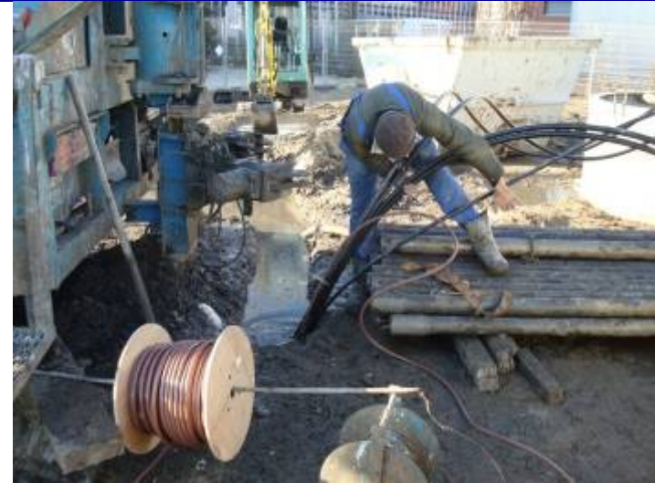
Einbau Erdwärmesonden
