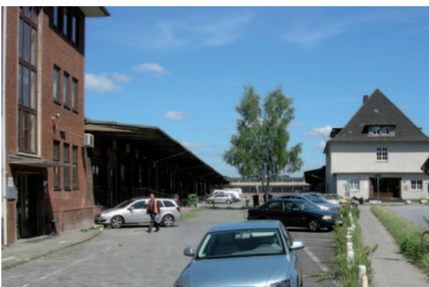
Südliche Hallen, Gleisdreieck Altona
