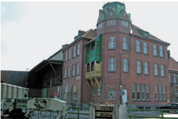
Kopfbau der 50er Schuppen im Hafen
