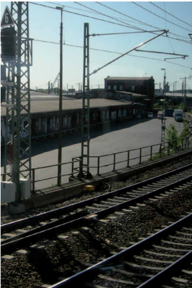
Blick von der Fernbahntrasse Richtung Oberhafen
