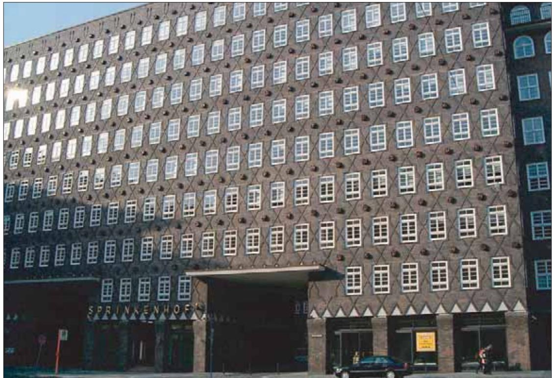
Das Gebäude ist als Skelettbau konstruiert. Die Konstruktion verbirgt sich jedoch hinter dem charakteristischen Dekor der Wandflächen aus Klinker, die von den Gersons entworfen wurden.
