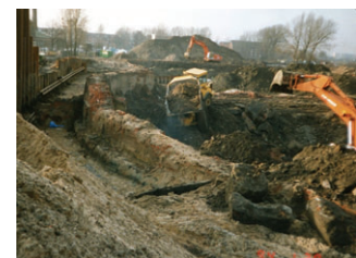
1/1994: Ausbau der Gasometerverfüllung
