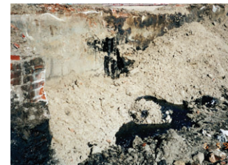
Teer im Bereich der Gasometerringe
