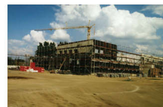
Neubau des HWW-Technik-Zentrums
