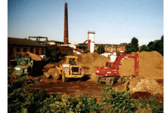
8/1993: Abtrag belasteter Böden
