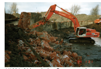
1/1994: Abbruch des Gasometerringes
