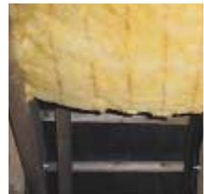
Die Dämmung muß lückenlos und sorgfältig verlegt werden. Dabei sind auch die Anschlüsse an die Dämmung der Außenwände zu beachten (siehe Seite 11: Wärmebrücken).
