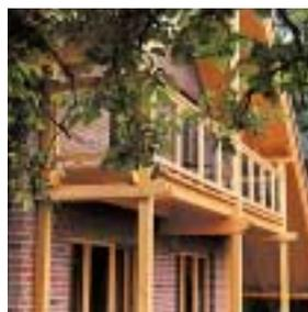
Auskragende Bauteile, z.B. Balkone: Durch vorgesetzte Holzkonstruktionen wird die notwendige thermische Trennung erreicht.
