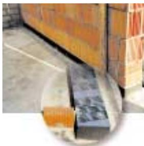
Anschluß Sohlplatte - Außenwand: Einsatz eines wärmedämmenden Materials als untere Steinreihe.
