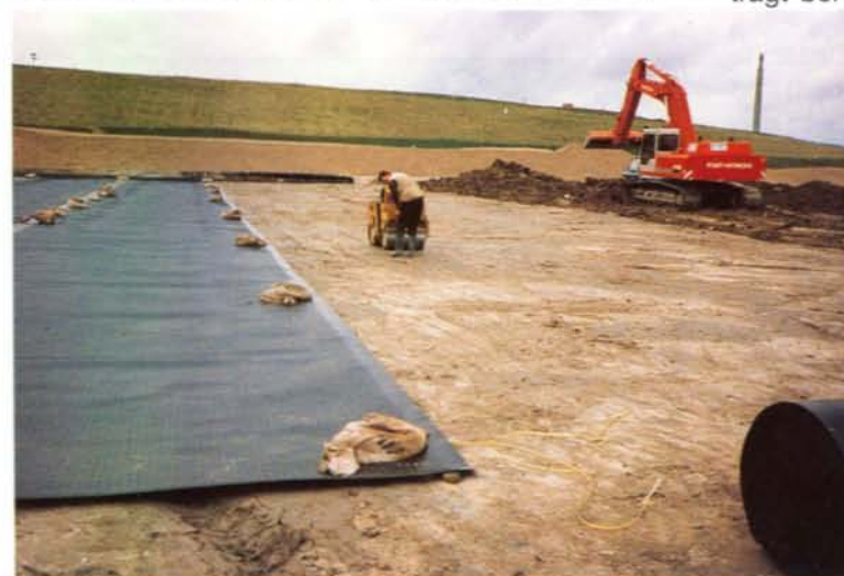
Abb. 4.7 Verlegung der HDPE-Bahnen auf der mineralischen Dichtung
