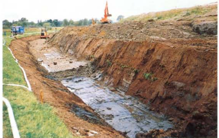
Abb.4.5 Profilierte alte Deponieoberfläche am Deponiefuß
