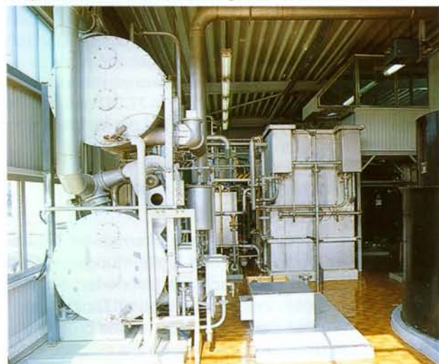
Abb.5.5 links Aktivkohlefilter, im Hintergrund die Flotationsanlage
