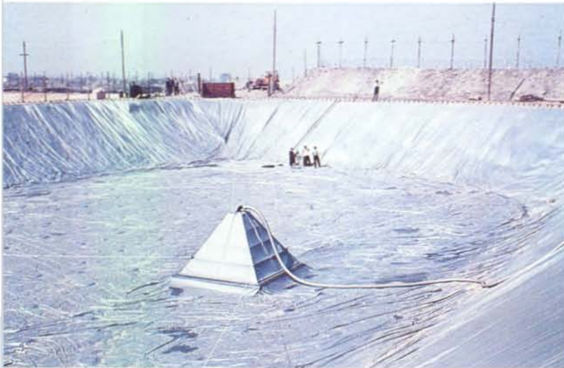
Abb. 1.9 Flüssigabfallbecken im Bau
