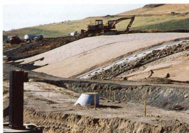
Abb. 4.8 Einbau obere Flächendränage und Decksubstrat
