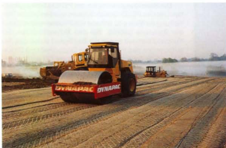
Abb. 4.6 Verdichtung der mineralischen Dichtung mit einer Vibrations-Glattradwalze
