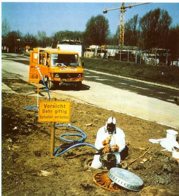
Abb. 8.4 Arbeiten im Schutzanzug und mit Atemschutz
