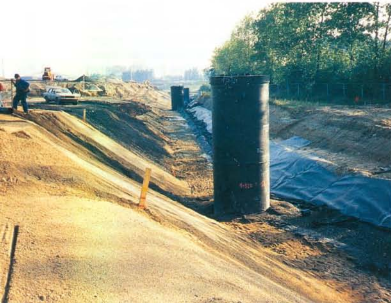
Abb.4.9 Einbau der Schächte für Sickerflüssigkeiten am Deponierand
