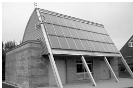
Dies ist das Heizungshaus der Umweltsiedlung.
