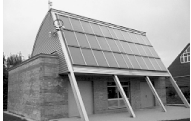
Heizungshaus mit Gas-Brennwertkessel (Foto: Walensky)
