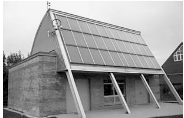
Heizungshaus mit Gas-Brennwertkessel (Foto: Walensky)
